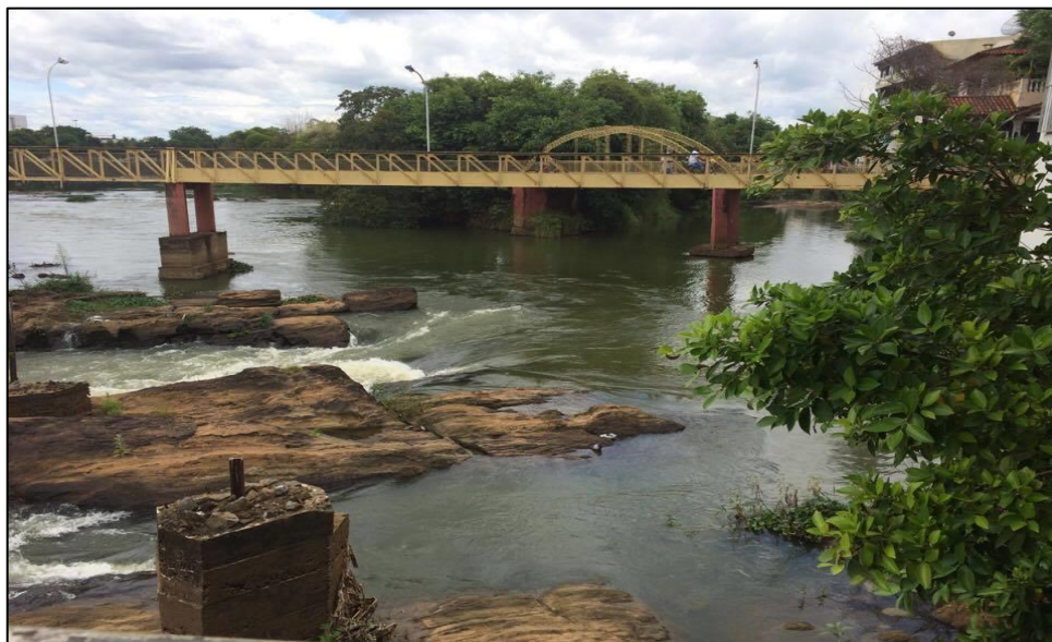
Figura 10. Ponte de Ferro. Santo Antônio de Pádua/RJ.
