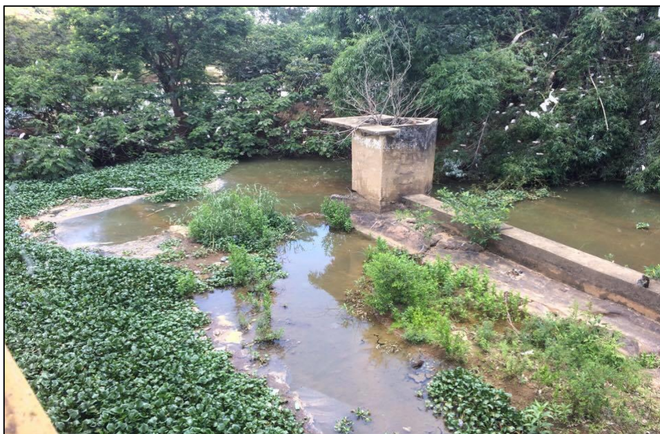
Figura 11. Um ângulo de observação da Ponte de Ferro, Santo Antônio de Pádua/RJ.
