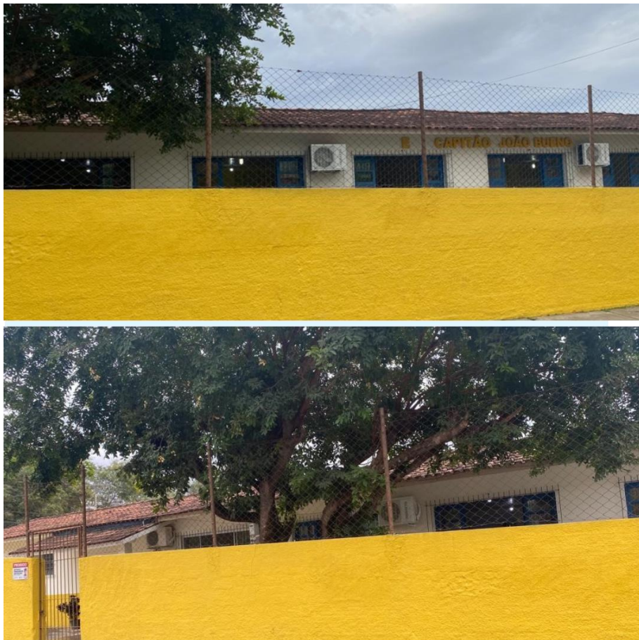
Figura 6 – O exterior da escola
