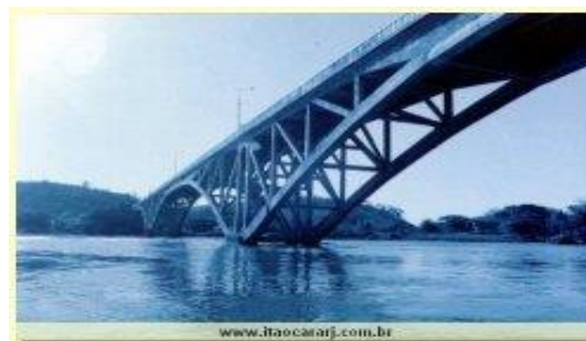
Figura 2: Ponte Ary Parreiras
