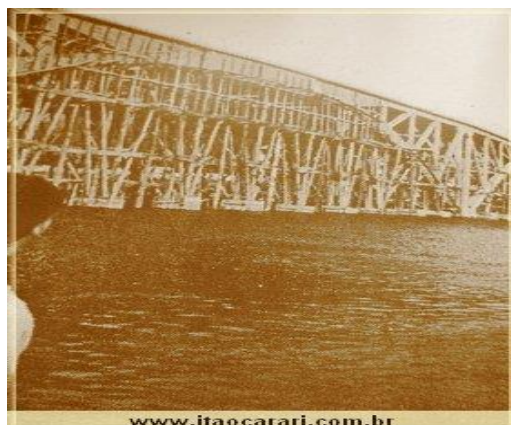
Figura 3: Ponte Ary Parreiras
